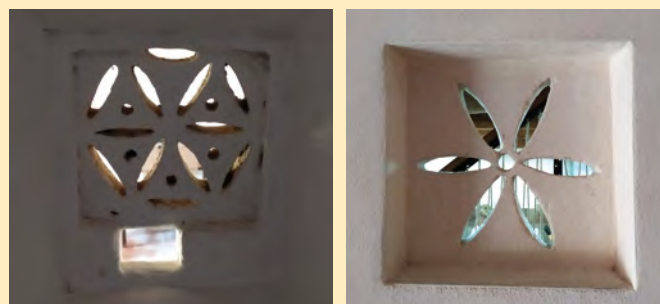
► 1.- Espiera de la masia de Can Fàbregues de Sant Martí Sadevesa, a l'alçada de mitja escala de pujada al primer pis. (Foto de Pere Rovira). 2.- Espiera de Cal Damià de Terrassola que estava tapiada, apareguda en les obres de remodelació de part de la casa l'any 2012, a mitja alçada de l'escala que mena al primer pis. (Foto de Pere Rovira).
