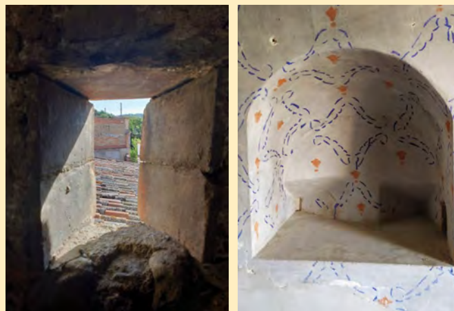
► 1.- Espitllera de Cal Xacó de Terrassola, que dona a un teulat veí. (Foto d'Anna Maria Rius). 2.- Espitllera doble a una banda de la sala del primer pis de la masia de Can Fàbregues de Sant Martí Sadevesa (Terrassola), i encarada de davant cap a darrere. A l'altra banda del pis, n'hi ha un altra de simple. (Foto de Pere Rovira).
