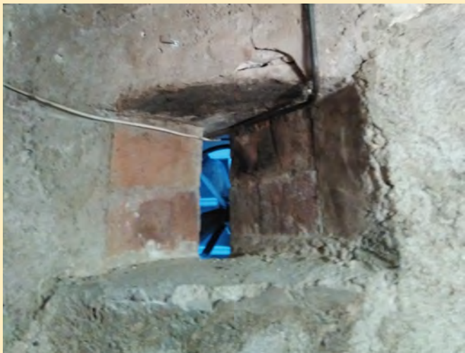
► Espitllera a la masia de l'Arboçar (Lavit), que dona a la banda del Torrent de l'Almirall. Curiosament, l'embigat del sostre està reforçat amb una petita biga travessera. (Foto de Pere Rovira).
